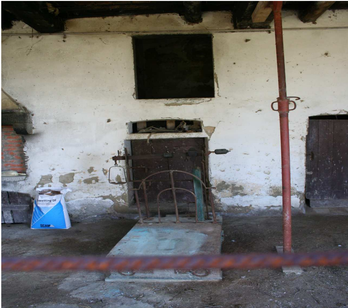
FOTO 9 – Il Poggiale I° - Porticato di ingresso – Particolare –
