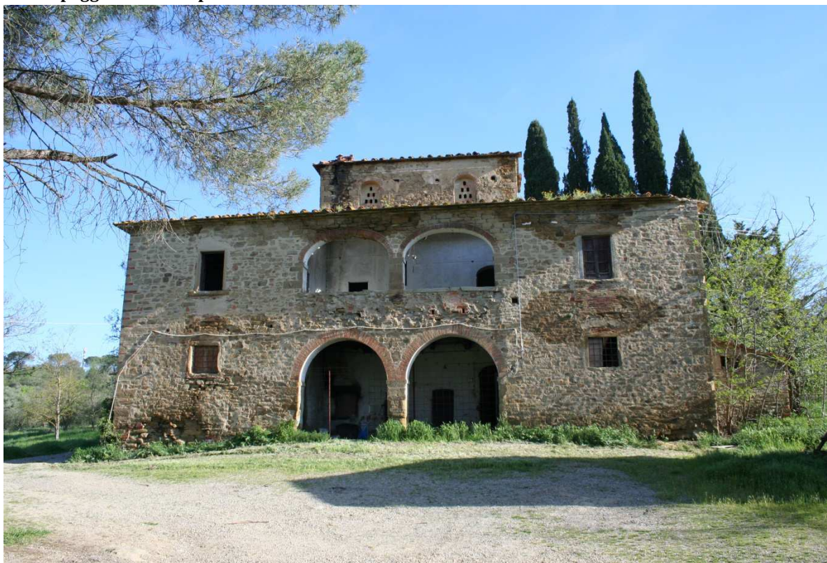
FOTO 2 - Il Poggiale I° - Prospetto Sud –
