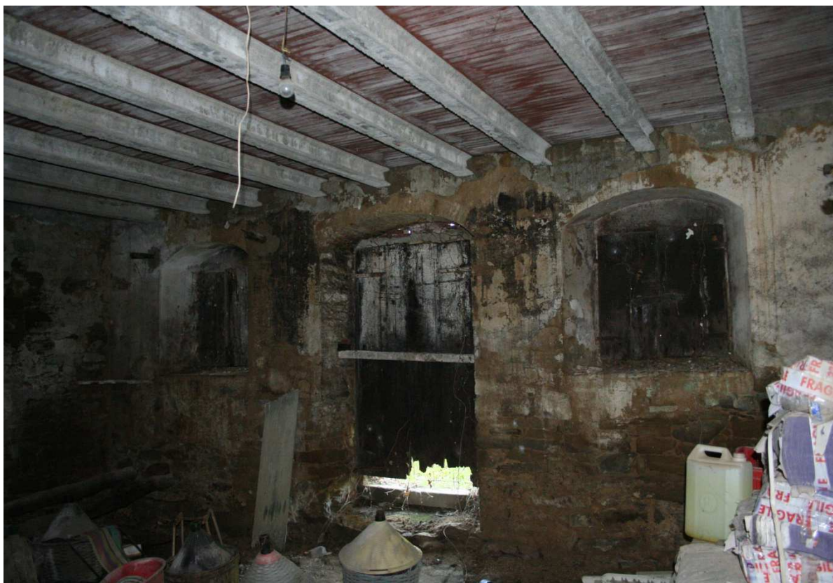
FOTO 13 –Il Poggiale I° - Vano n.7 P. Terra deposito prodotti agricoli
