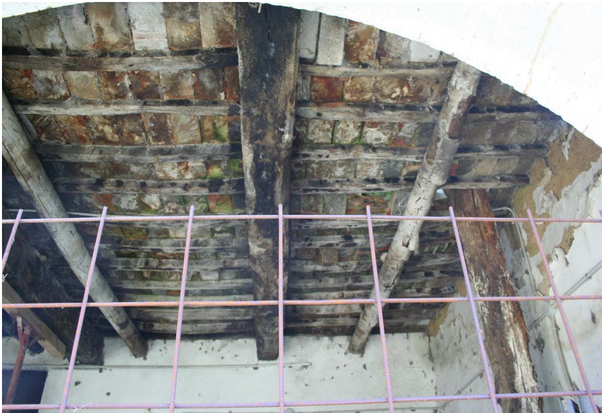
FOTO 8- Il Poggiale I° - Porticato di ingresso – Particolare solaio di copertura
