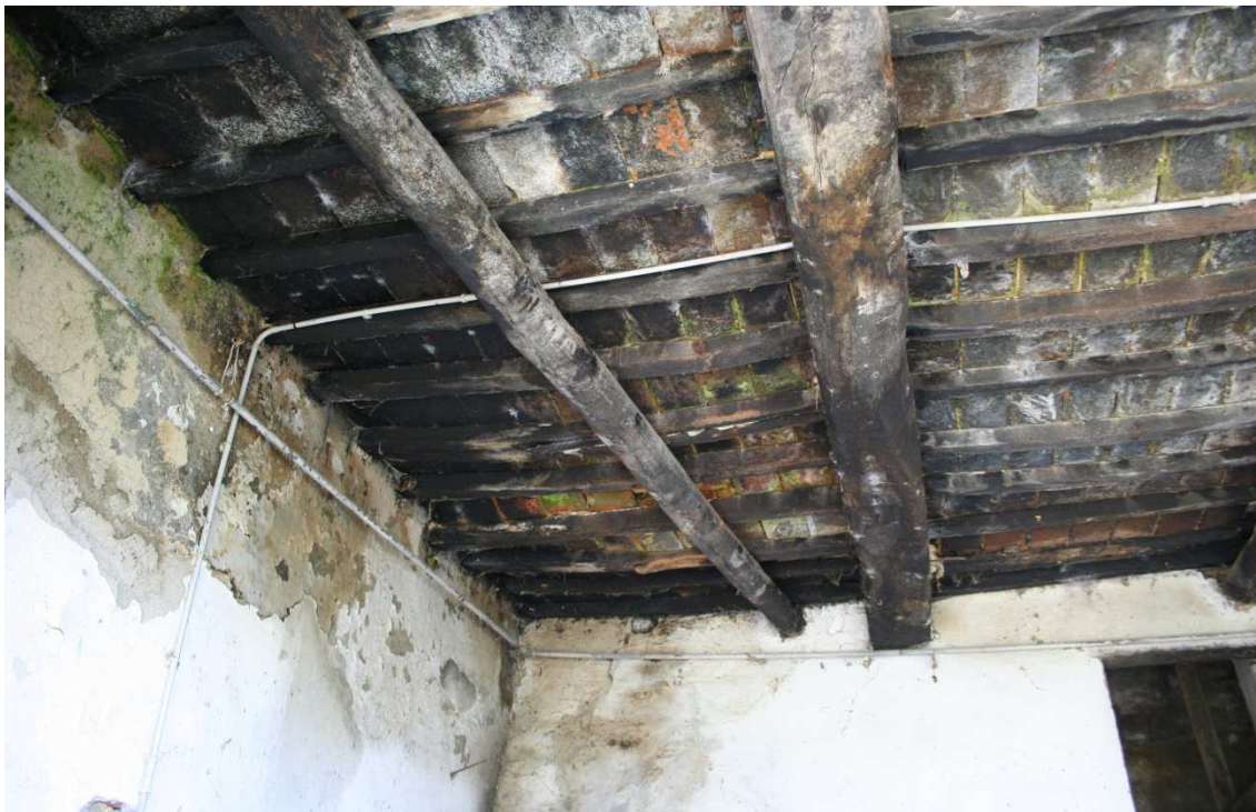
FOTO 10 – Il Poggiale I° - Porticato di ingresso – Particolare solaio di copertura
