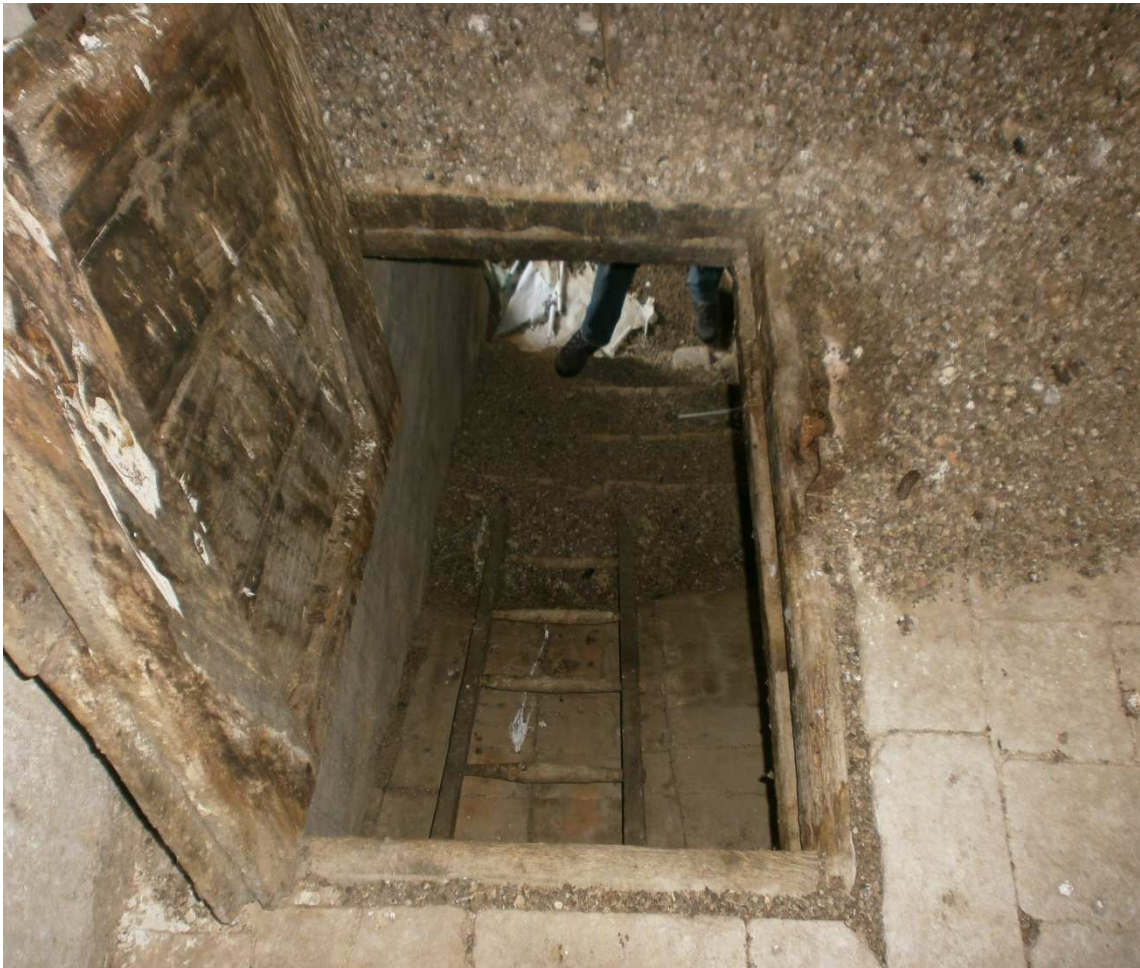
FOTO 35 –Poggiale I° - Botola di accesso alla Colombaia
