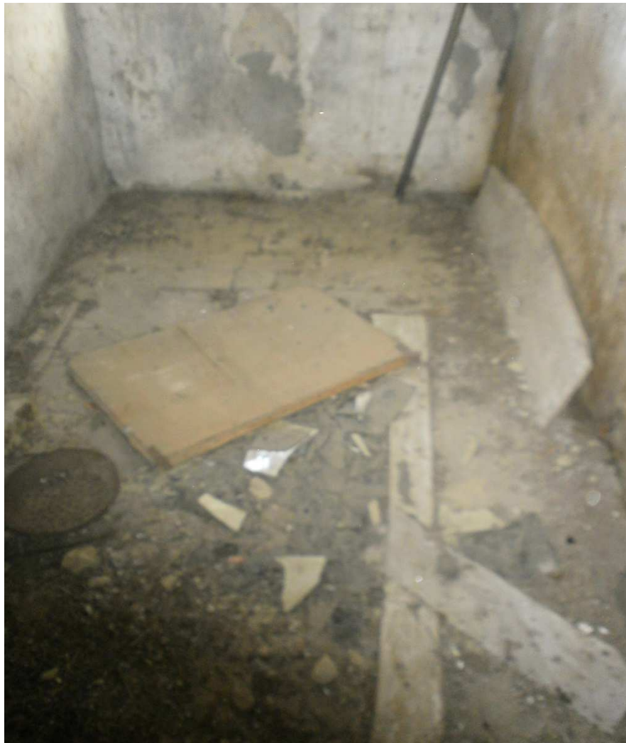
FOTO 25 –Poggiale I° - Vano n.7 a P. Primo
