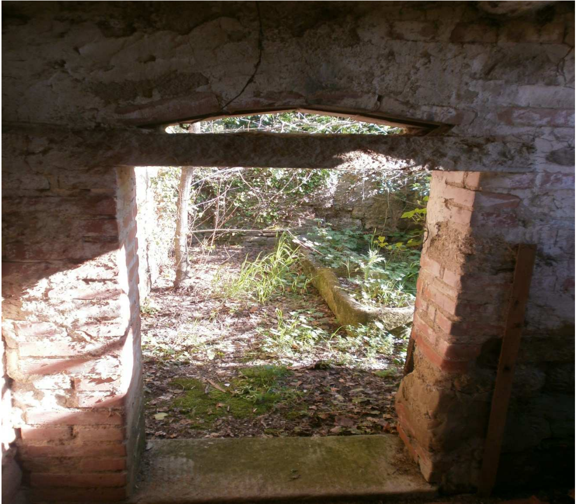
FOTO 19- Il Poggiale I° - Vano 11 P. Terra –Porcile esterno
