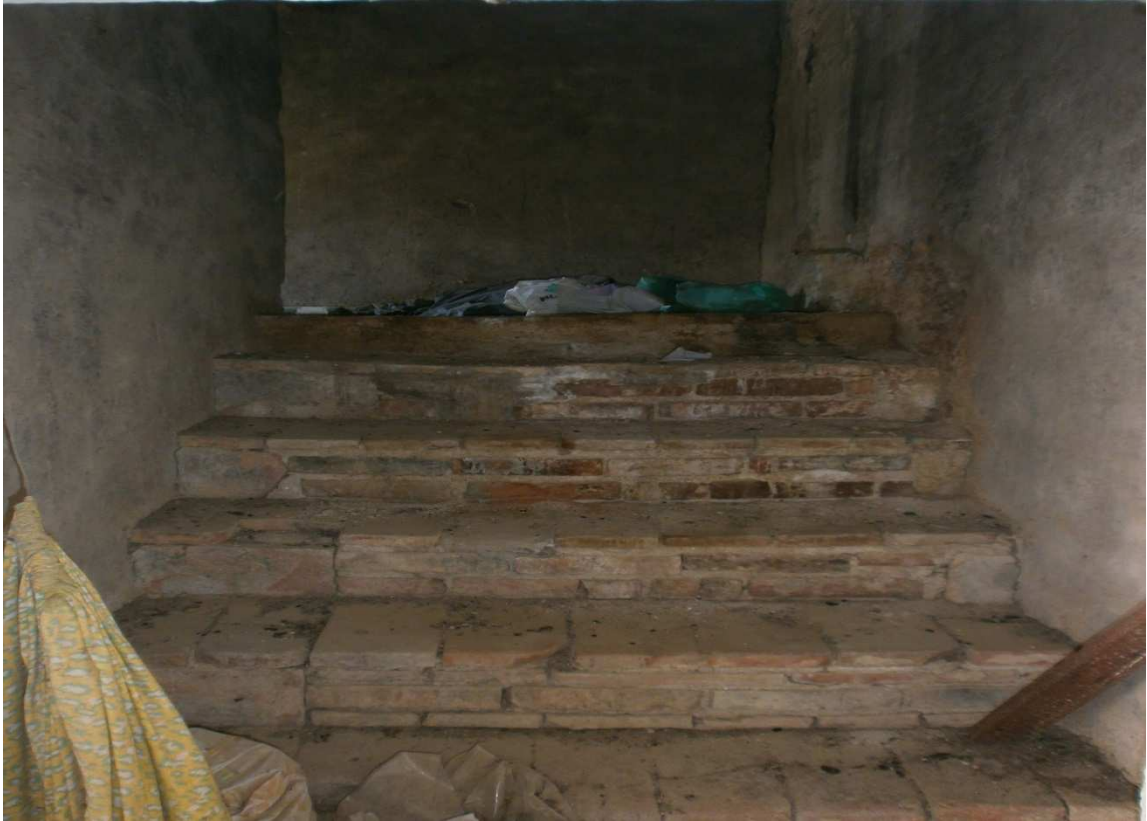
FOTO 33- Poggiale I° - Vano scala di accesso alla Colombaia
