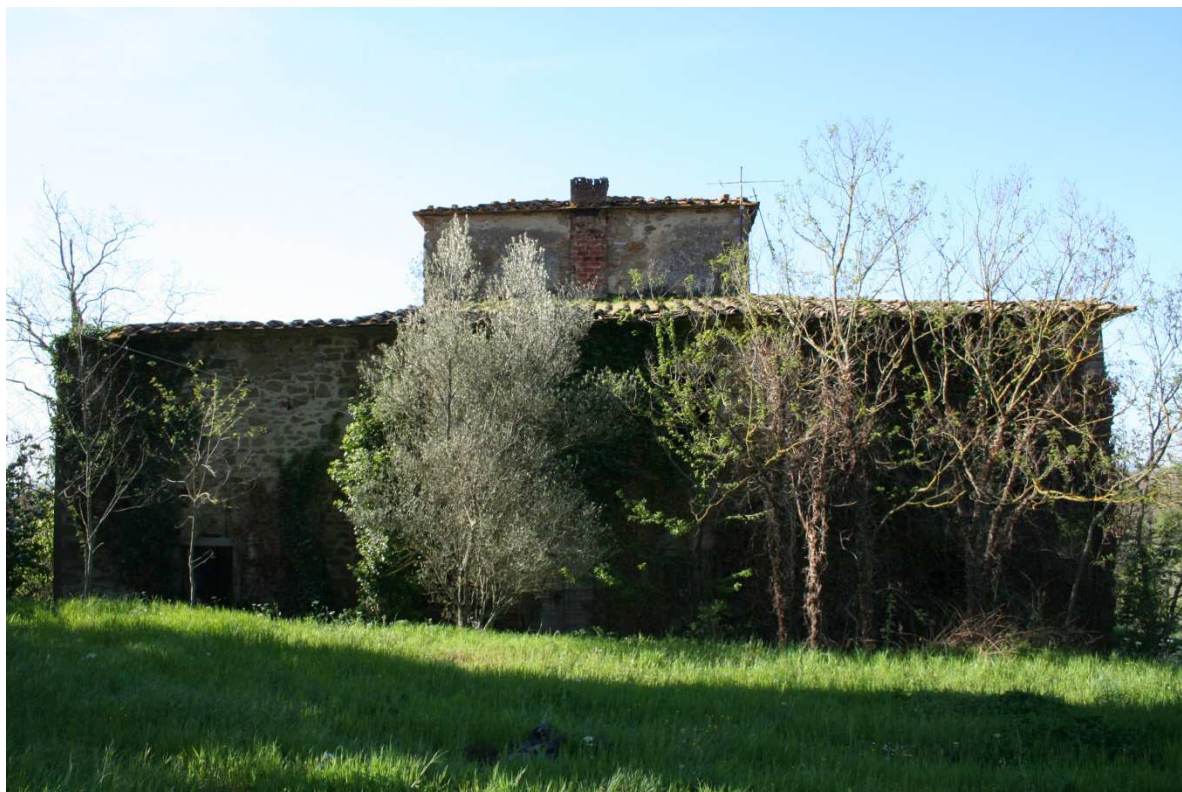
FOTO 5 – Il Poggiale I° - Prospetto Nord (Retro)
