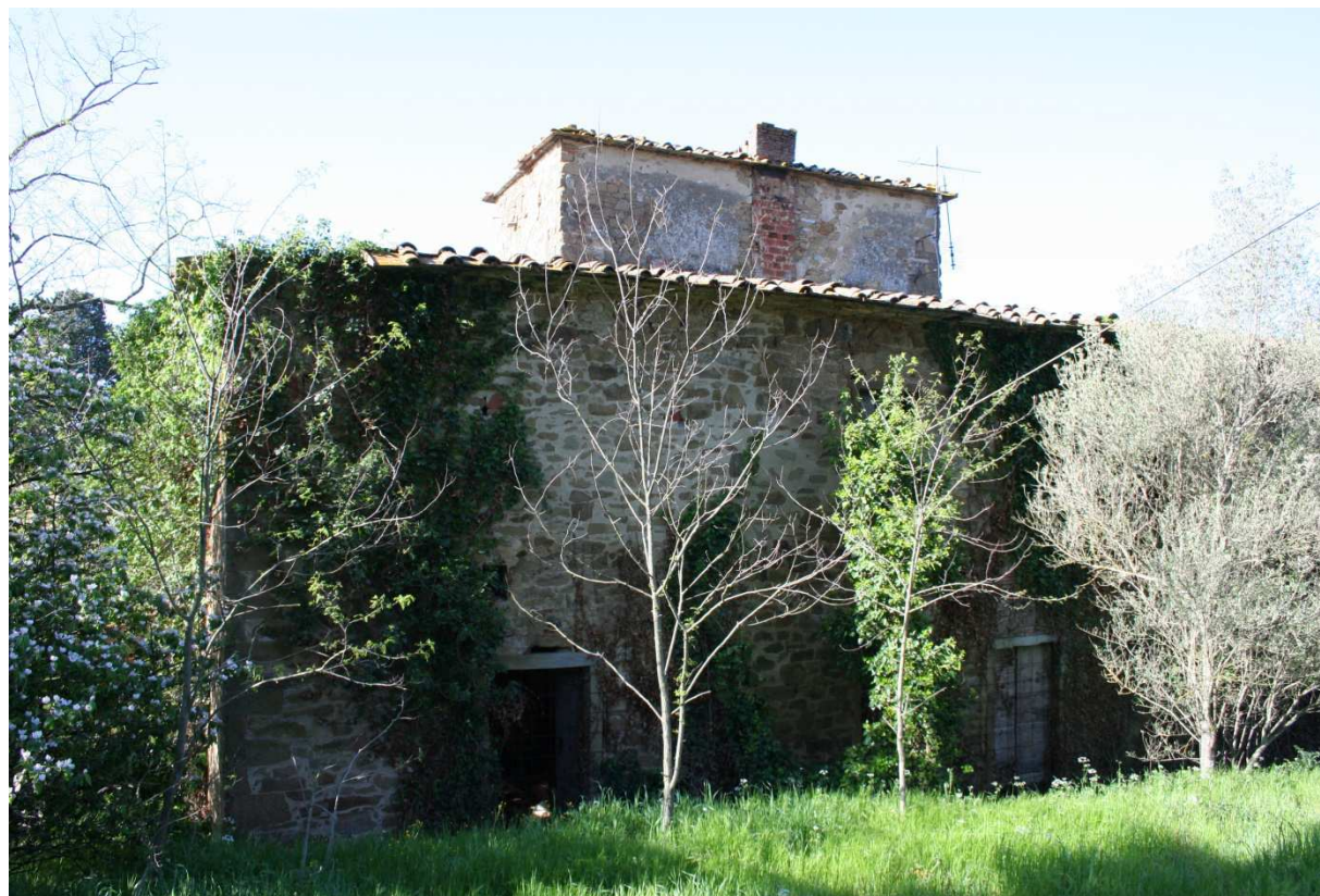
FOTO 6 – Il Poggiale I° - Prospetto Nord (Retro)
